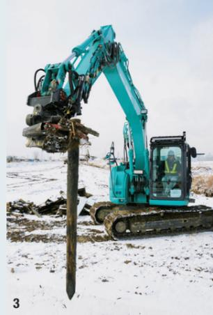
常磐自動車道のスマートインターチェンジ工場の作業風景。3Dマシンガイダンス搭載のSK135SRDが付けた頭切りの位置に従い、2Dマシンガイダンス搭載のショベルで法面の追っかけ施工を行っている
