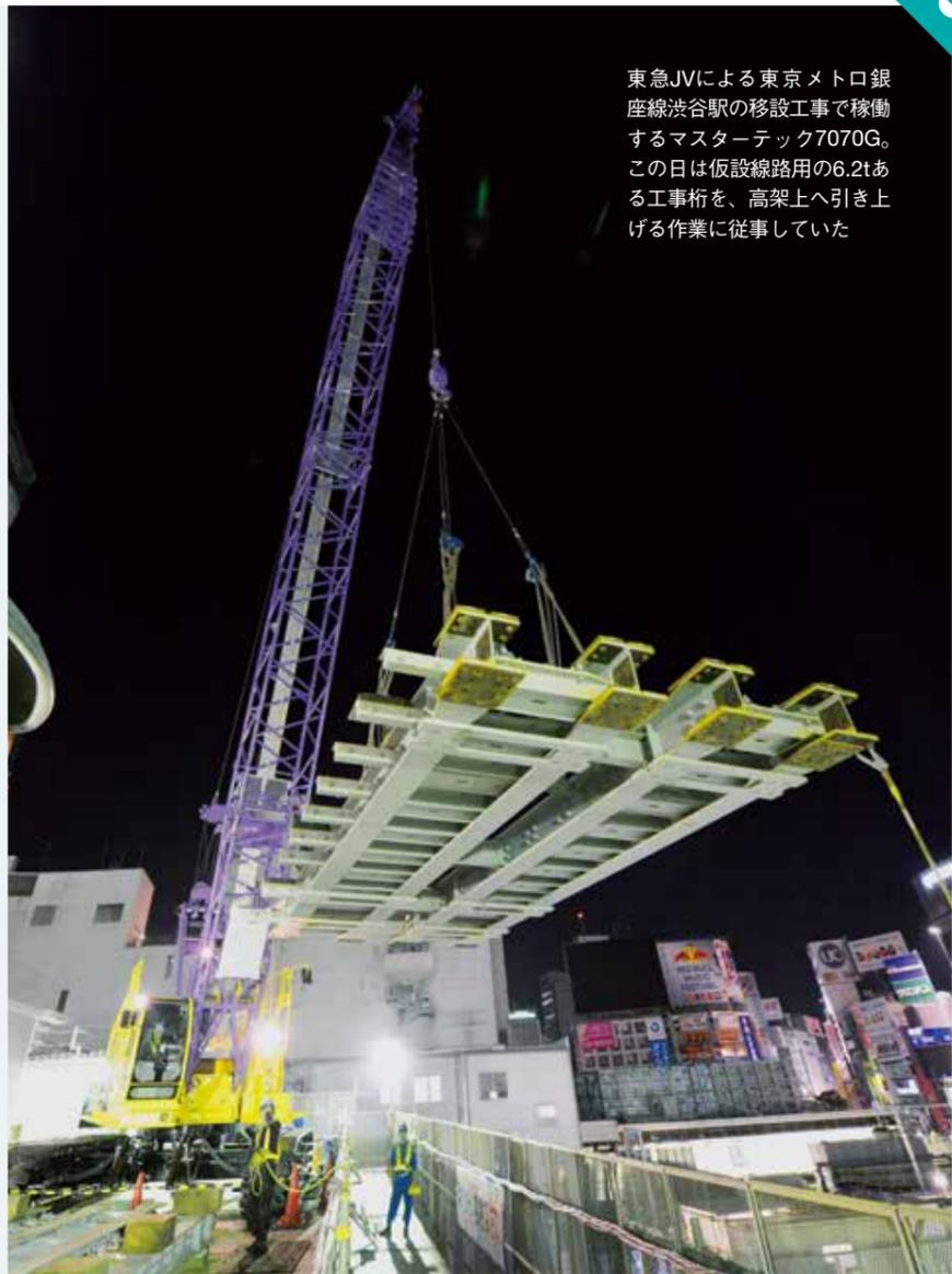
東急JVによる東京メトロ銀座線渋谷駅の移設工事で稼働するマスターテック7070G。この日は仮設線路用の6.2tある工事桁を、高架上へ引き上げる作業に従事していた
