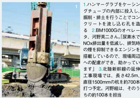
1.ハンマーグラブをケーシングチューブの内部に投入し、掘削・排土を行うことでコンクリートを流し込む孔を造る 2.BM1000Gのオペレータ、河野英二さん。「尿素水でNOx排出量を低減し、排気時の煙を抑制できるエンジンを搭載しているので、現場周辺への配慮ができ、助かっています」 3.北陸新幹線の延伸工事現場では、長さ42.5m、直径1500mmの杭を約700本打つ予定。河野組は、そのうちの約100本を担当
