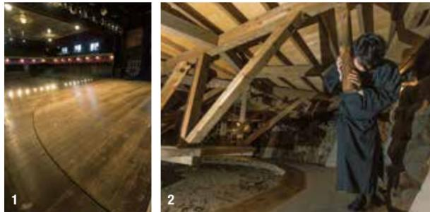
1.2.直径9.73mの回り舞台。舞台下に設置されたるくる仕掛けを黒子4人で回し、重さ約2tの舞台を動かす 3.舞台上側から見た「切穴」の仕掛け。人が乗ると約300kgの重さになるため、滑車を使って2人がかりで昇降操作を行う
