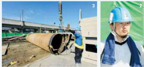
ります。そのため、地面と垂直に杭を打ち、安定度を上げる必要があります。その作業は実に困難。しかし、この工法はほかの工法よりも高い精度で垂直に杭を打てるため、近年は採用率が高まっています。「河野会長、そんな全周回転式オールケーシング工法だが、ケーシングチューブや全周機などの設備投資に資金がかかるため、中国地方で手がけられるのは河野組を含めて3社のみ。本工法を中国地方で初導入し、多数の実績がある同社では、最近では工事が途切れる期間がないという。
