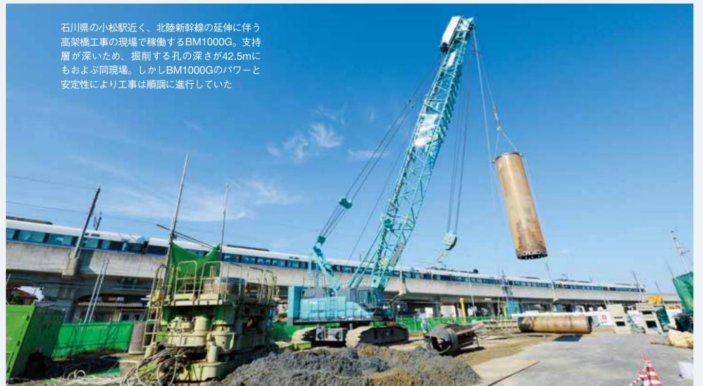
は、クレーンのサイズにも波及しており、河野組でも大型クレーンの増車により対応している。その際選ばれたのがコベルコのBM800GとBM1000Gだった。代表取締役社長の河野賢次さんは、その経緯をこう語る。「クレーン導入時は他メーカーの機種も含めて比較検討するのですが、オペレータが推すのは常にコベルコ。今回もオペレータの意見を尊重しました」2017年の8月末に導入されたBM1000Gは現在、石川県で北陸新幹線の延伸工事に伴う高架橋の基礎杭打ちに従事。河野社長の子息であるオペレータの河野英二さんは、同機のパフォーマンスを絶賛している。「基礎工事では重量物の移動が多く、例えば全周機ともなると約40tの重量があるもので、70tクラスのクレーンでは荷の重さで車体の後方が浮き上がってしまうことがあります。その点100tクラス
