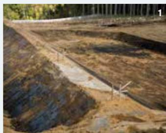
1.新東名高速道路本線の中央分離帯となる部分。この工区では2016～20年の工期で約32万㎡の土砂を掘削するため、SK200H-10はフル稼働。ハイブリッドならではの燃費効率が効果を発揮している 2.法面整形の作業は繊細さを要する。オペレータの技術とシヨベルの操作性が問われる場面だ
