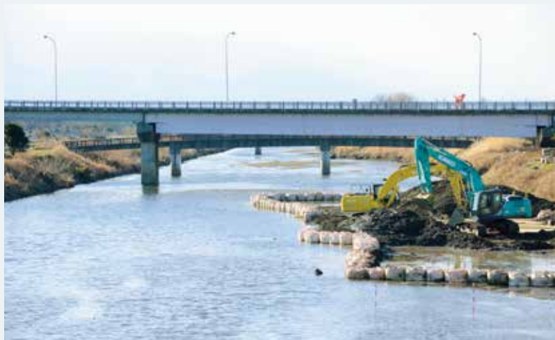
河床から2000㎡の土砂を掘削して整形する本工事は、従来なら2カ月の工期がかかるが、ホルナビ+PLUS搭載機の導入で2～3週間の工期短縮ができる予定だ
