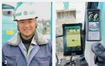
1. 従来の浚渫作業では、土砂の掘り過ぎが多く、運搬コストが余計にかかるケースも多かった。だが、一度で高精度の整形ができるホルナビ+PLUS搭載機なら、そうした心配は無用だ 2. モニタで車体の水平具合さえ見ておけば、設計図通りに仕上げるのが可能 3. 「丁張りや水中に入って目安杭を打つ作業も不要になりました」と、元請け会社の永井建設・小南和幸さんは、人員縮小につながるICT施工を歓迎する
