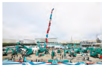
会場中央には作業高さ65m超のSK 3500Dを展示
