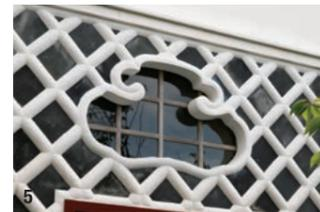
4.船の発着の確認や、密輸がないように入国船を見張った塔屋。約15mの高さは当時新潟随一を誇った 5.なまこ壁ときんちゃく型のガラス窓。地元の大工が西洋建築を見よう見まねで造った擬洋風建築と言われるが、随所に伝統的な和の意匠も見られる
