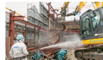
1.狭小地の解体現場には小旋回モデルが最適。周囲を必要以上に気にすることなく操作できると、オペレータにも好評だ。2.3階建ての鉄骨の解体に活躍するSK235SRDLC。1台が鉄骨を持ち、もう1台が切断する抜群のコンビネーションで解体作業を安全に行っていた
