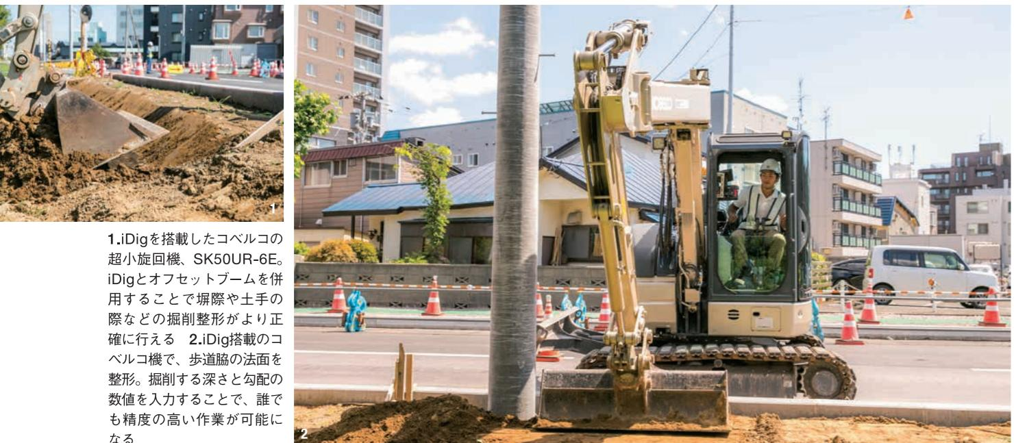
1.iDigを搭載したコベルコの超小旋回機、SK50UR-6E。iDigとオフセットブームを併用することで堀際や土手の際などの掘削整形がより正確に行える。
