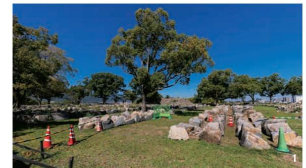
1.回収した石垣の石は、後に積み直す時まで城内外の石置き場に並べられる（二の丸催し広場）2.補修できなかったものは交換石材を新たに作成する（天守閣）（写真提供：熊本城総合事務所）
