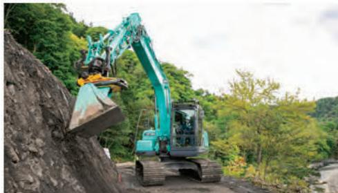
機械を移動させることなくバケットを斜面の角度に合わせられるため、足場を整える手間を減らせ、狭所でも安心して作業ができる
