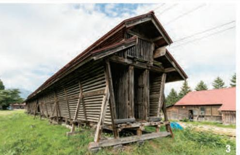
1.四階倉庫（1916年建設）は、その名の通り木造4階建ての巨大な作業場兼貯蔵庫。内部にはエレベーターが設置されている。2.木造平屋建・寄棟造で屋根に望楼が付いた本部事務所。小岩井農場の中核を担う施設で、今も現役の事務所として活躍中。3.牛の飼料となるトウモロコシの乾燥・貯蔵用の小屋。最大12棟あったうち4棟が現存（写真是最も古い明治末期頃のもの）。斜めの柱に沿ってルーバー状の壁が付き、雨が当たらない構造となっている。
