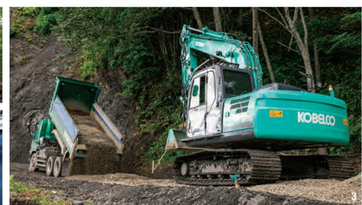
1.バケットの着脱をキャブから降りることなく行えるうえ、しっかりと取り付けられているかを音と光で知ってくれる安全装置が付いている 2.チルトローテータはバケットのチルト(傾き)と回転を左右のレバーで操作する。「右がチルト、左が回転という操作にも1週間ほどで慣れました」(玉木さん) 3.砂利の敷きならし作業も、チルトローテータを活かせば効率的
