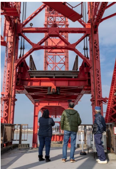
船舶の通行が優先されていたため、列車が通る時以外は、可動部は23mの高さまで上げられていた。時間通りに昇降するため、時計代わりにしている人もいたという
