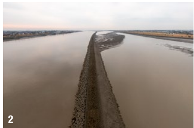
1.明治以降、国内で建設された可動橋は100を超えるが、昇開式の可動橋としては現存する国内唯一のもの 2.引き潮の時にだけ見られるデ・レーケ導流堤。おびただしい数の自然石をアーチ状に積み上げて築かれている（昇開橋の下流側にある新田大橋から有明海方面を見て） 3.昭和40年頃の筑後川昇開橋（写真提供：財団法人筑後川昇開橋観光財団）
