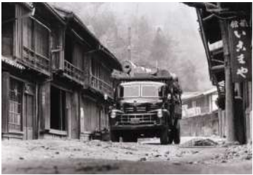
復元保存工事が始まる前の寺下地区の様子（昭和40年頃）
