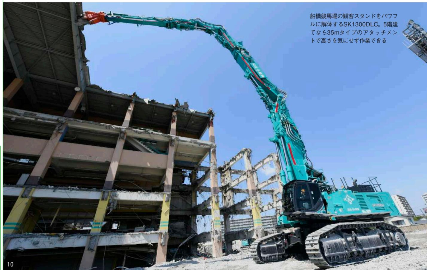
船橋競馬場の観客スタンドをパワフルに解体するSK1300DLC。5階建てなら35mタイプのアタッチメントで高さを気にせず作業できる
