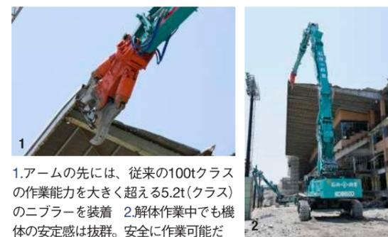
1.アームの先には、従来の100tクラスの作業能力を大きく超える5.2t(クラス)のニブラーを装着 2.解体作業中でも機体の安定感は抜群。安全に作業可能だ
