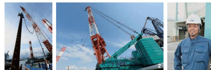
1.パイプロハンマーに鋼管矢板をセットし、いよいよ打ち込みへ。本現場では、1週間の工期で計14本を打ち込む予定だ
