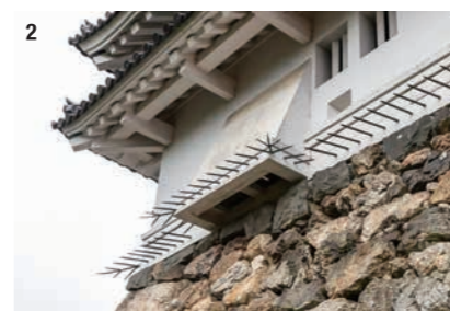
1.高さ約13mの三ノ丸石垣は、1601年の築城開始から10年を要し最後に完成した。多くの面が自然石の形を活かした野面積みで構築されている 2.天守の北面には、石垣に登る敵に備えた「石落とし」と「忍び返し」の鉄串が並ぶ
