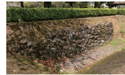
戦国時代末期に長宗我部元親が築いたと考えられる石垣。2000年に実施した三ノ丸の試掘確認調査で見つかった。山内氏が構築した三ノ丸石垣に比べると石材は全般的に小ぶりである
