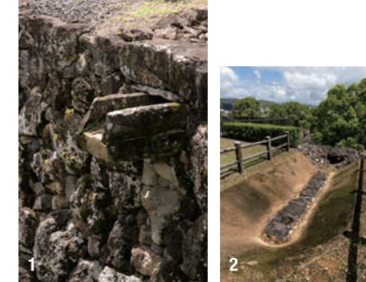
1.石垣上部に突き出す石樋は、城内に雨水が溜まるのを防ぐ排水設備。本丸や三ノ丸などに16カ所確認されている 2.三ノ丸の土中で見つかった排水用の水路遺構。石組みの暗渠(あんきょ)の先には石樋があり、石樋から雨水が放出される。水路遺構は露出展示され見学が可能だ
