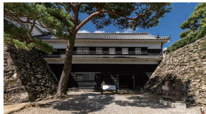
1.本丸と二ノ丸の間をまたぐように設けられた詰（つめ）門。敵がこの門を突破しても本丸から遠ざかるようなつくりになっている 2.詰門の二階部分は二ノ丸と本丸を結ぶ通路になっており、藩主のもとに向かう武士の詰所となっていたことが門の名前の由来 3.本丸の南側を固める黒鉄（くろがね）門。扉の外側に、黒漆で塗られた鉄板が打ち付けられている。儀式の際に藩主が出入りする門だった
