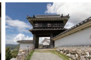
1.本丸と二ノ丸の間をまたぐように設けられた詰（つめ）門。敵がこの門を突破しても本丸から遠ざかるようなつくりになっている 2.詰門の二階部分は二ノ丸と本丸を結ぶ通路になっており、藩主のもとに向かう武士の詰所となっていたことが門の名前の由来 3.本丸の南側を固める黒鉄（くろがね）門。扉の外側に、黒漆で塗られた鉄板が打ち付けられている。儀式の際に藩主が出入りする門だった
