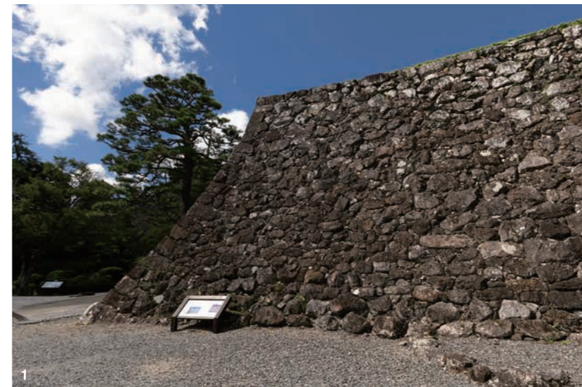
1.高さ約13mの三ノ丸石垣は、1601年の築城開始から10年を要し最後に完成した。多くの面が自然石の形を活かした野面積みで構築されている 2.天守の北面には、石垣に登る敵に備えた「石落とし」と「忍び返し」の鉄串が並ぶ
