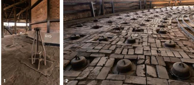
1.2階部分には煙突の周囲にダンパーが配置され、これを開閉することで排煙を制御した 2.1階の焼成室へ燃料となる粉炭を投下する投炭孔。1つの焼成室に5×5列で計25カ所、窯全体では400カ所に配置された。積まれた煉瓦に均一に粉炭が行き渡る設計で、使用しないときは鉄の蓋で閉じられていた
