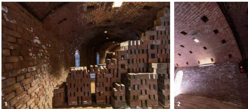
1.1階の焼成室では、煉瓦素地を井桁積みにした当時の様子が再現されている 2.天井の投炭孔の位置に合わせて煉瓦が積み、2階から投下される粉炭を効率的に受け止める構造となっている
