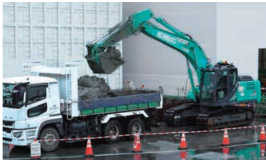
自動運転によるダンプ積込みの様子
