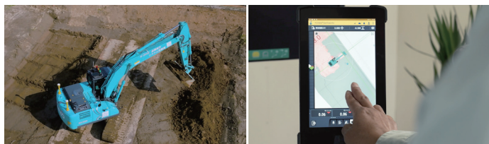
新潟県内での河川工事で遠隔施工を実施
