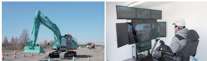
埼玉県内での河川工事で遠隔施工を実施
