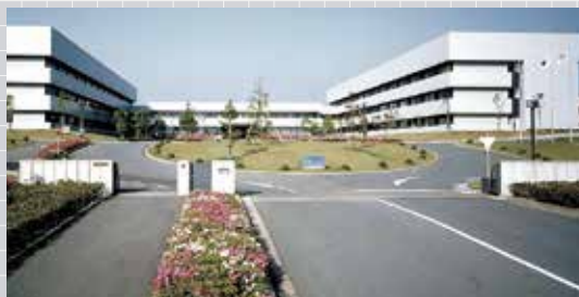
神戸製鋼所 神戸総合技術研究所
