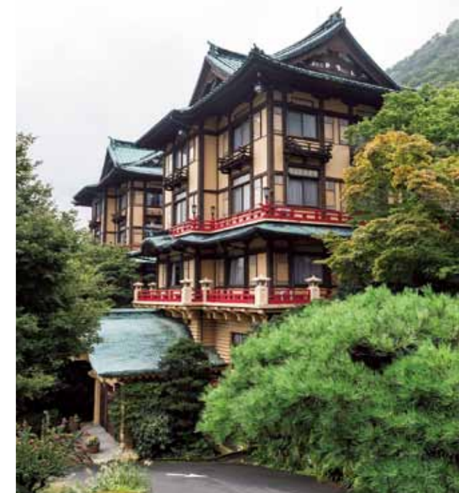
1936年に建てられた鉄筋コンクリート造りの宿泊棟「花御殿」。部屋番号の代わりに、43室すべてに異なる花の名前が付けられている
