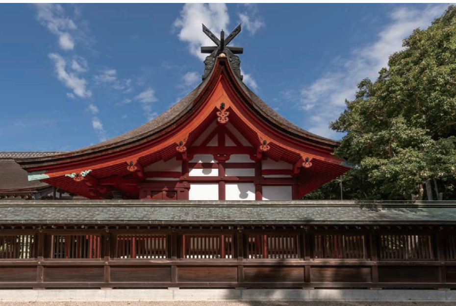
辺津宮の本殿は五間社流造で、薄い木板を幾重にも重ねた柿葺(こけらぶき)の屋根が特徴
