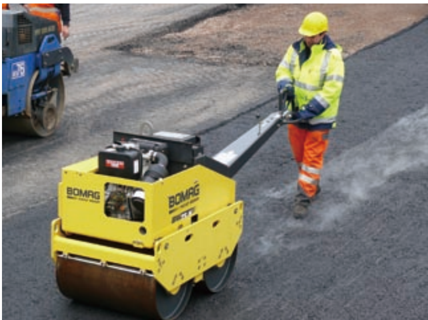
取り扱いが容易な油圧駆動式、両輪交叉振動ローラ
