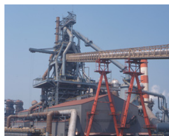
高炉プラント
