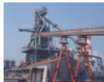
高炉プラント
