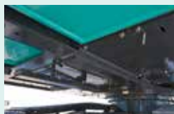
アッパ底部の鋼材補強
