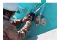
角度センサ等の 機器取付
