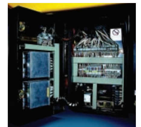
集中配線システム 迅速で容易な故障診断が可能
