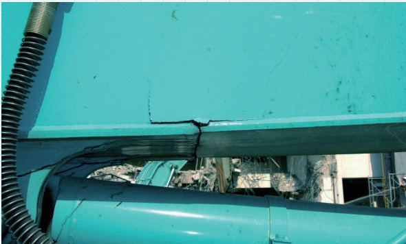
✓ 板と板の継ぎ目部分・板の曲がっている部分 シリンダーの付け根付近
